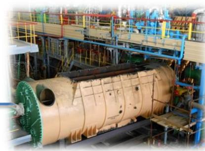
**замена медесодержащего оборудования (~1100 тонн на блок) 2-го контура Российских АЭС с ВВЭР-1000**
